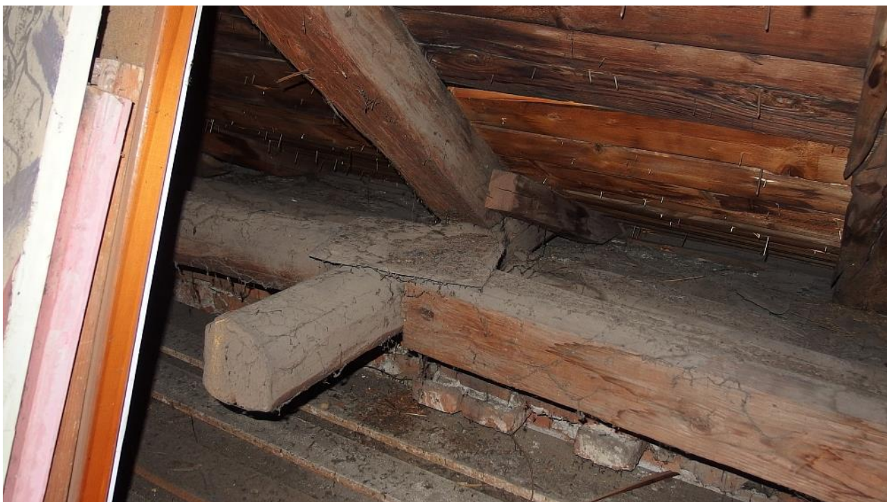
Zbytek vyřezaného vazného trámu na straně dvora
