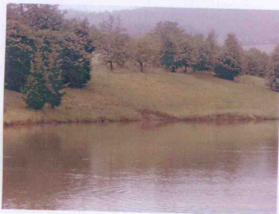
Mělký sesuv svahu na pravém břehu
