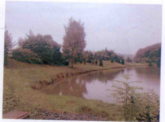
Břehová abraze podél celé nádrže
