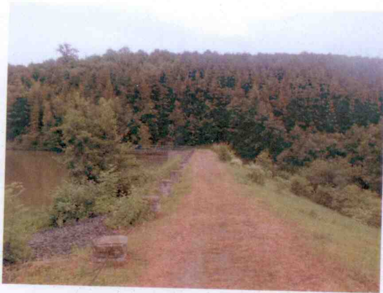
Pohled na korunu hráze
